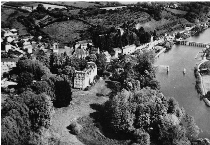
Le pont de bois dit "la passerelle".
