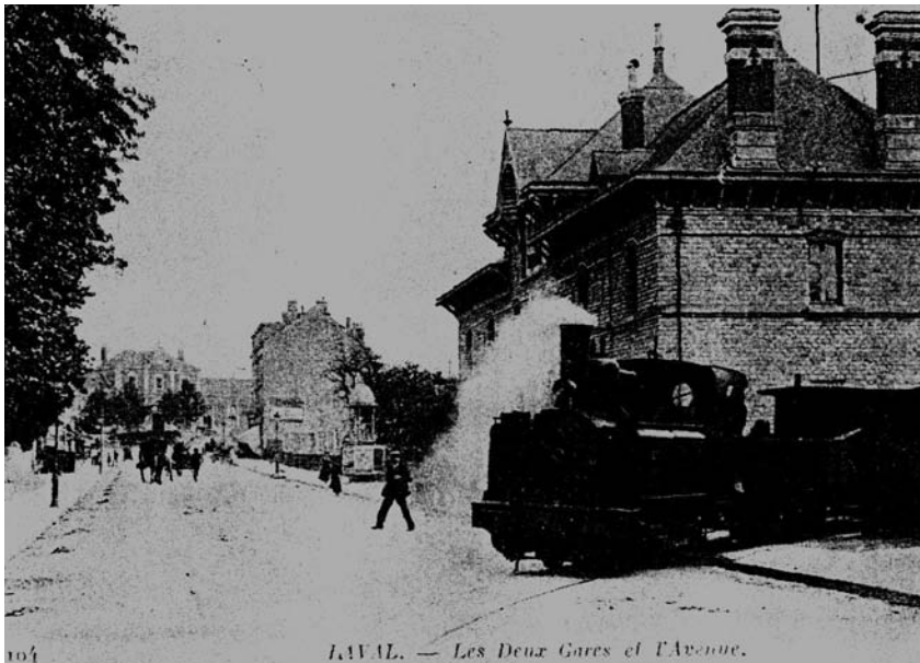
La sortie du tramway de la gare de départ à Laval.
